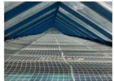
Le reti di sicurezza vengono divise in 4 sistemi denominati S, T, U, V, che differiscono fra loro per l'intelaiatura di sostegno dei bordi e per l'uso orizzontale o verticale. Essi sono diversi per la forma che assumono una volta installati e per la tecnica di messa in opera.
