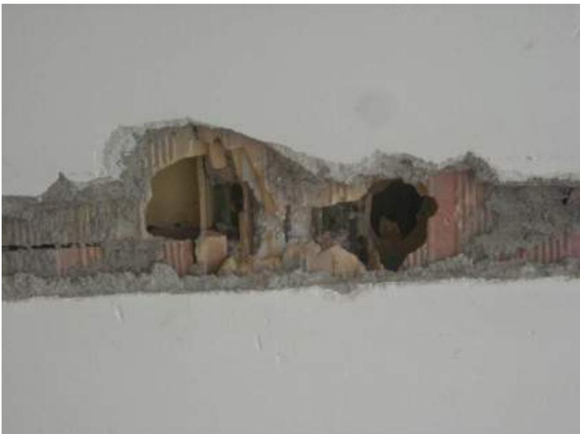
**Figura 22** – Saggio esplorativo solaio (SS3, Corpo A).
