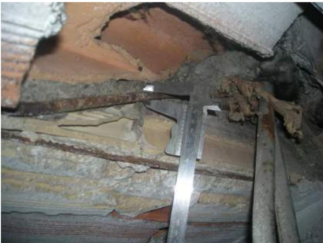
**Figura 24** – Saggio esplorativo solaio (SS4, Corpo B).
