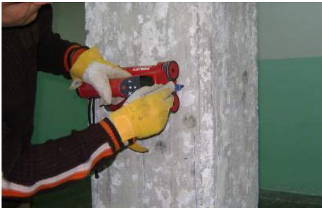
**Figura 9** – Pacometria eseguita sul pilastro P/PS/10 (Corpo C)
