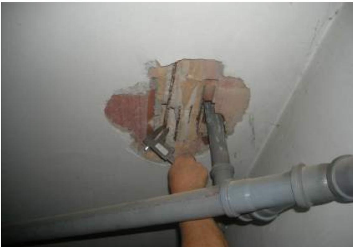
**Figura 21** – Saggio esplorativo solaio (SS2, Corpo A).
