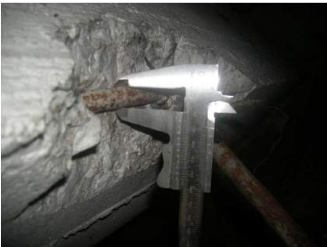
**Figura 25** – Saggio esplorativo trave:Ø14 (Corpo B, PS).
