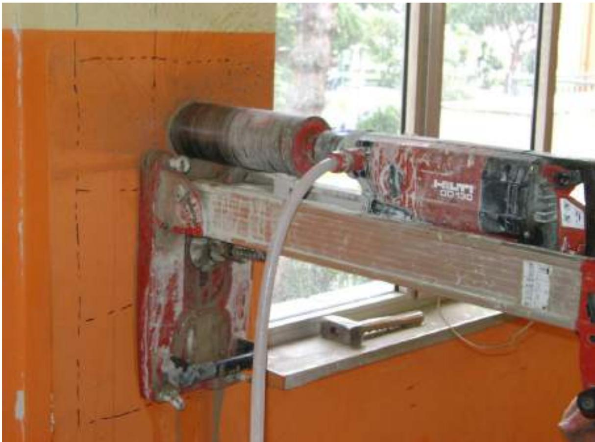
**Figura 10** - Esecuzione di un carotaggio in un pilastro.
