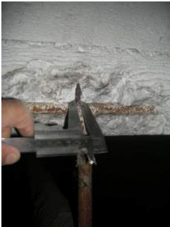
**Figura 26** – Saggio esplorativo trave:staffa Ø8 (Corpo B, PS).
