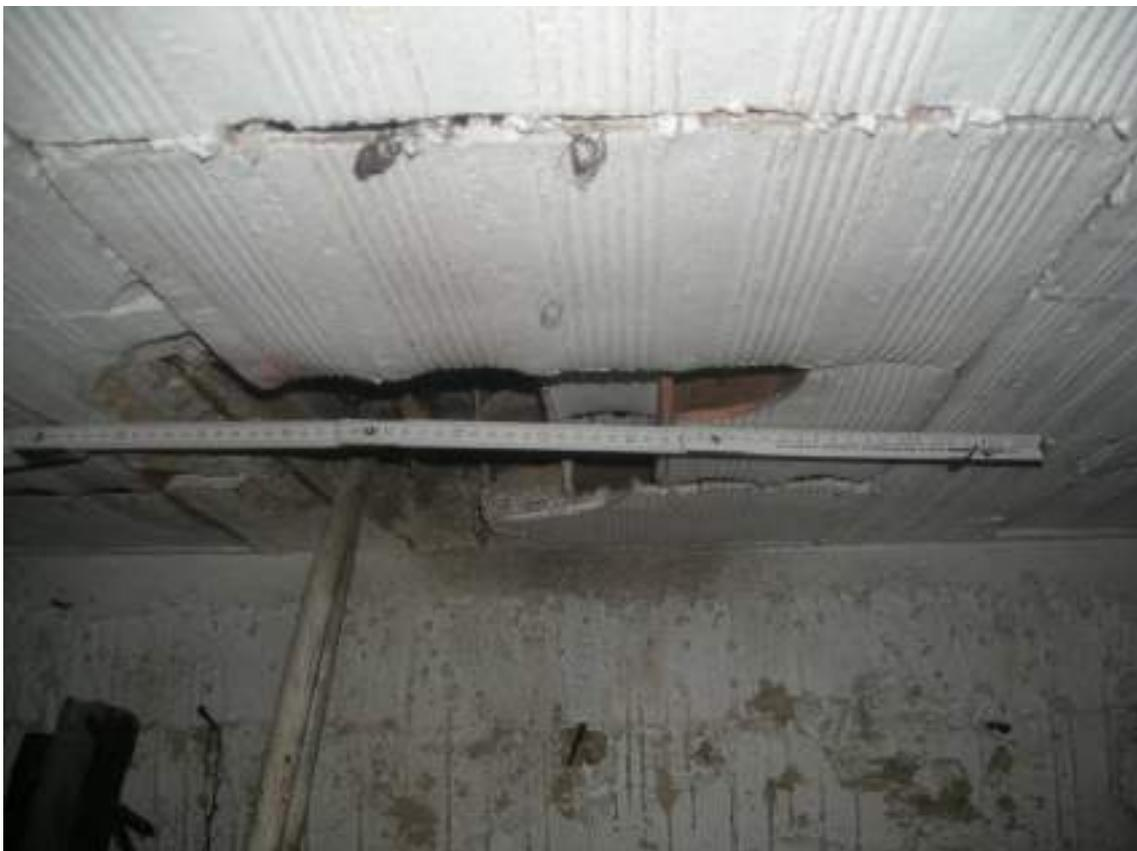
**Figura 23** - Saggio esplorativo solaio (SS4, Corpo B).
