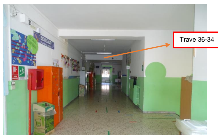
Figura 2: Trave emergente 36-34 ultimo impalcato
