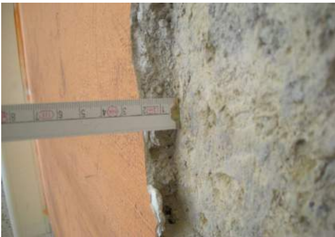
Figura 15 – Saggio esplorativo muratura: spessore intonaco (SM5, Corpo A).
