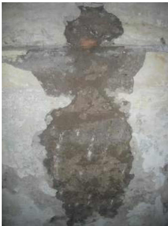
Figura 11 – Saggio esplorativo muratura PS: parete in calcestruzzo (SM2, Corpo A).
