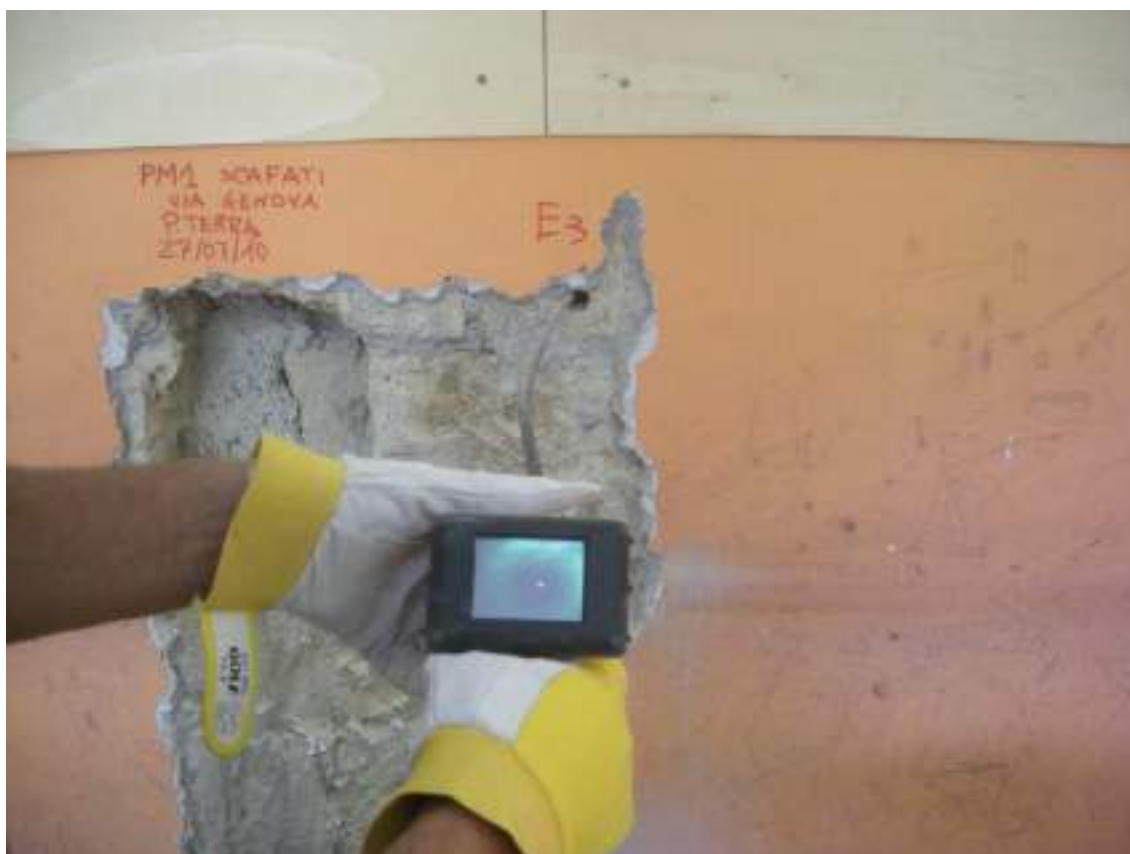
Figura 3 – Indagine endoscopica muratura (E3, Corpo A).
