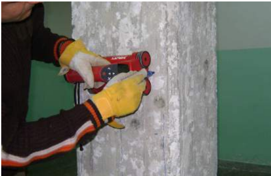
Figura 9 – Pacometria eseguita sul pilastro P/PS/10 (Corpo C)
