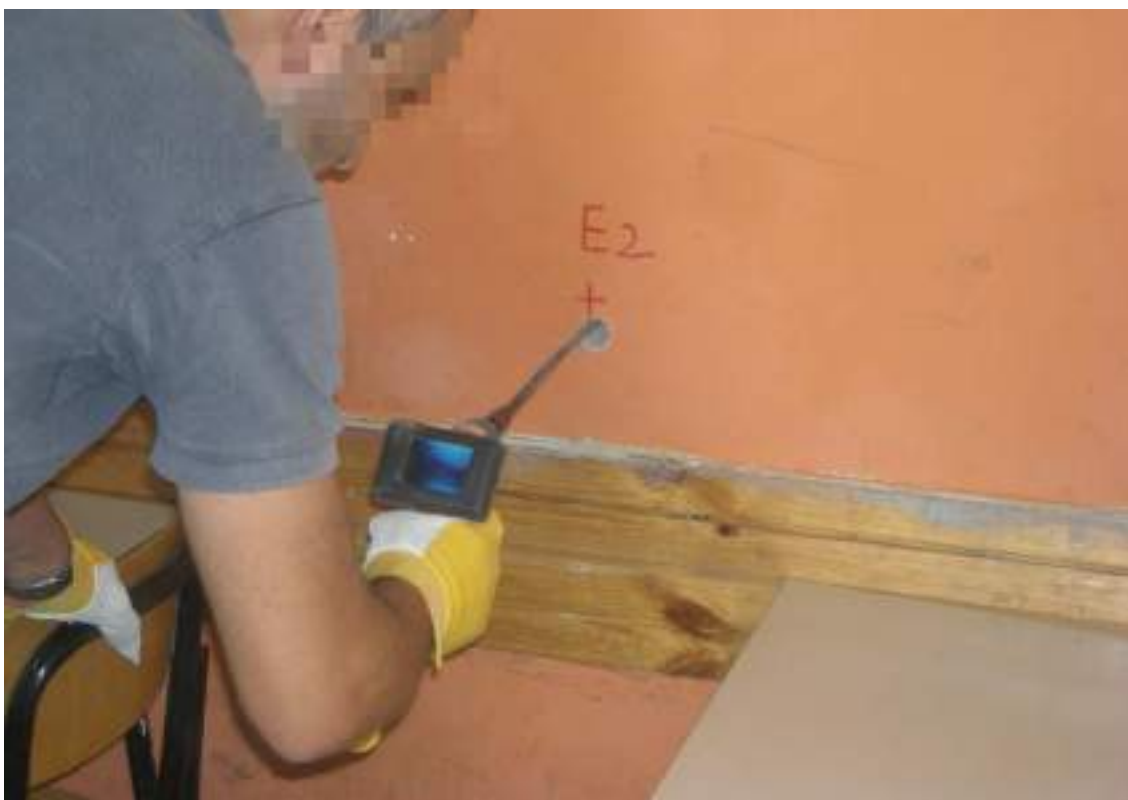
Figura 2 – Indagine endoscopica muratura (E2, Corpo A).
