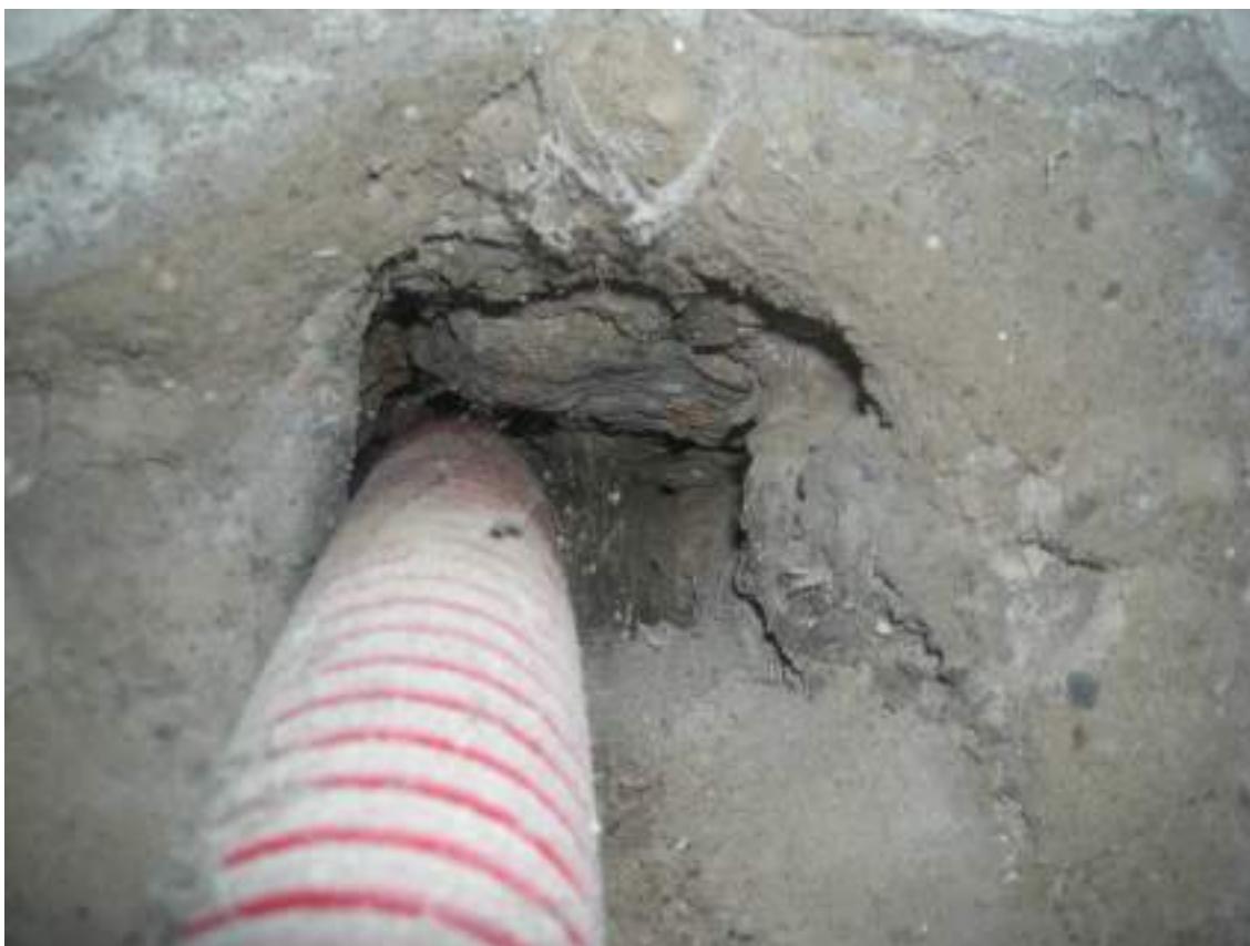
Figura 5 - Indagine endoscopica muratura in foro preesistente (Ea, Corpo A).
