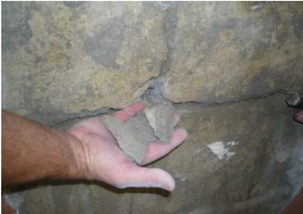
Figura 7 - Prelievo di malta.
