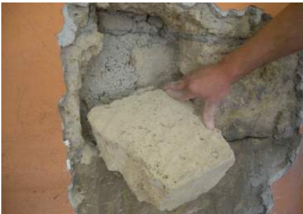
Figura 8 – Prelievo di mattone (Tufo)
