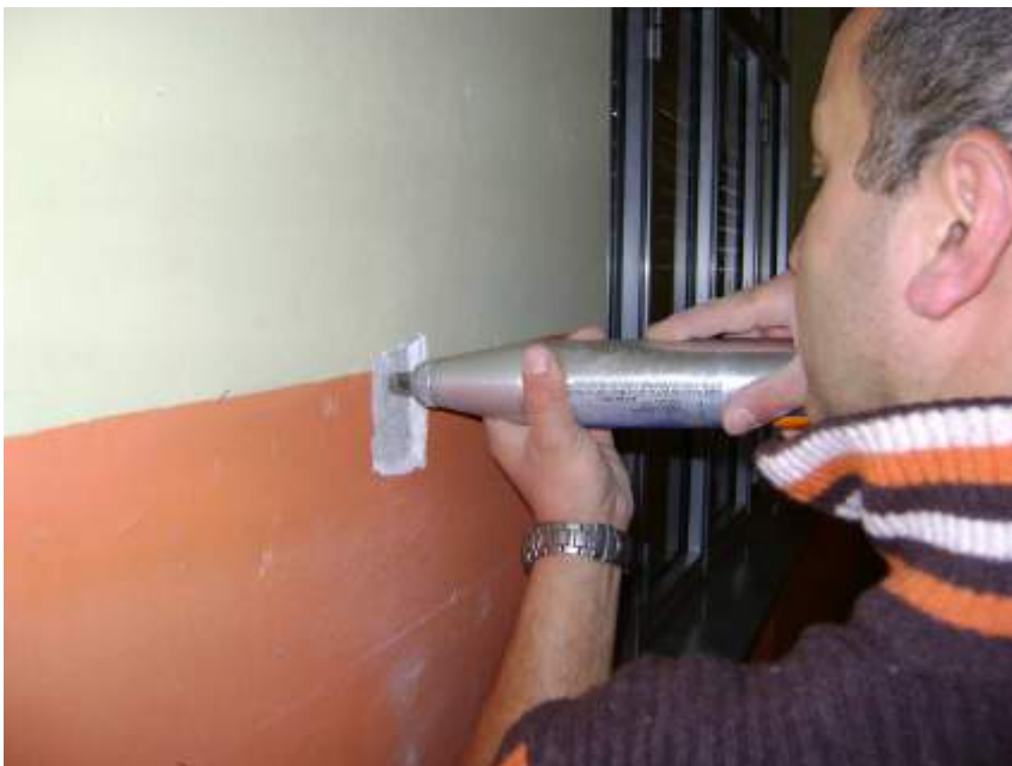
Figura 60 - Sclerometria pilastro P/PT/16
