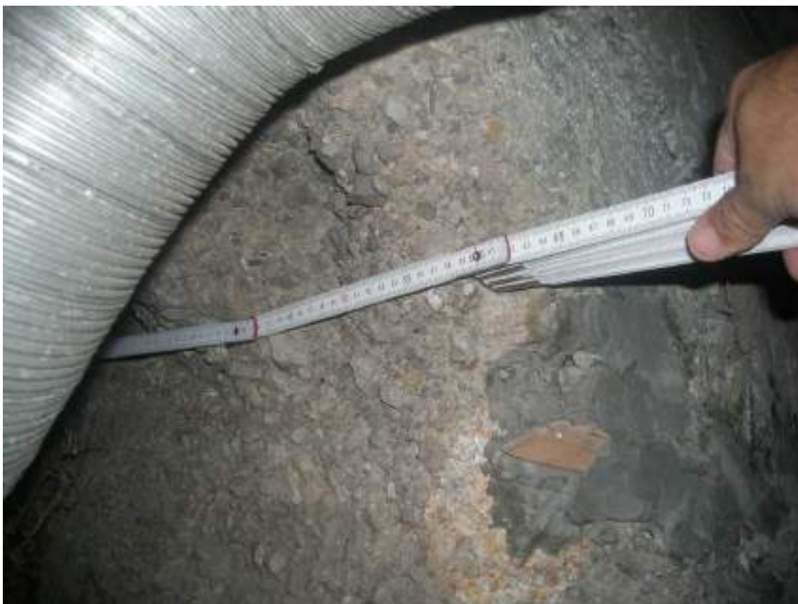
Figura 7 - Indagine endoscopica muratura in foro preesistente (Ec, Corpo B).
