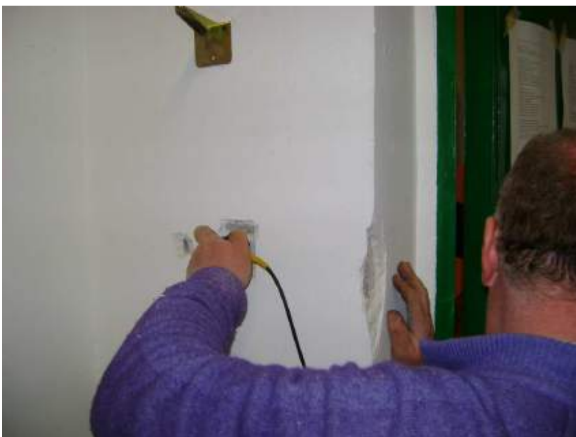
Figura 81 - Ultrasuoni pilastro P/1P/23
