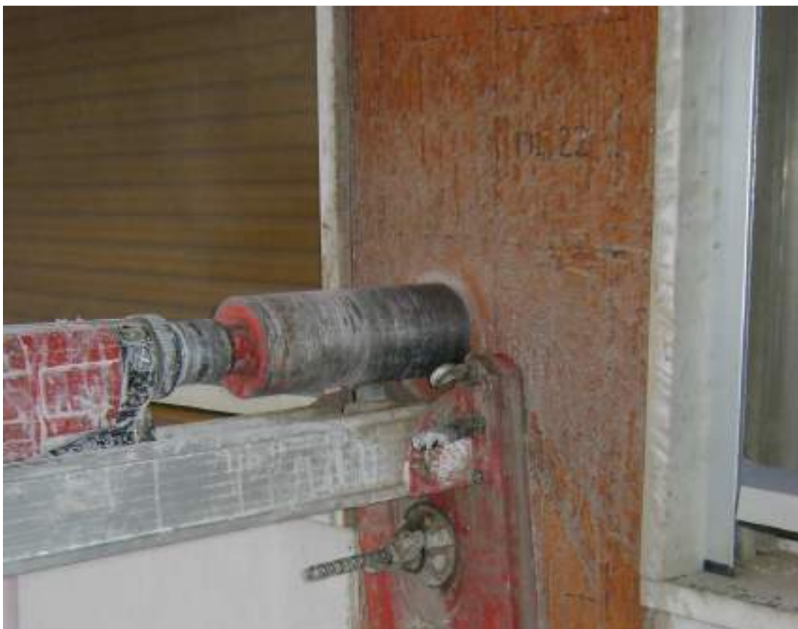
Figura 34 - Esecuzione carotaggio C3
