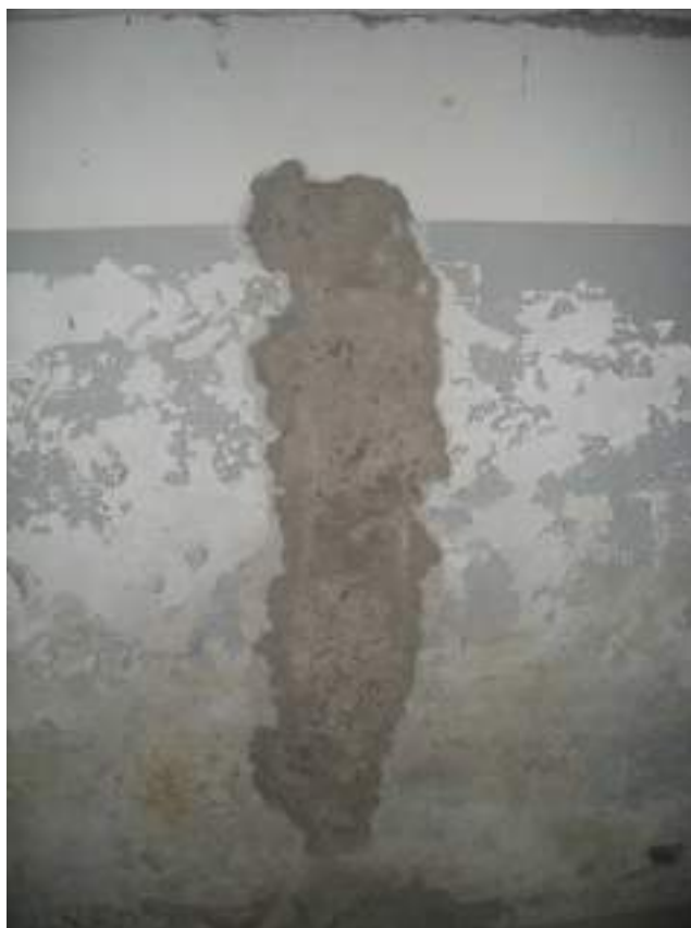
Figura 12 – Saggio esplorativo muratura PS: parete in calcestruzzo (SM3, Corpo A).
