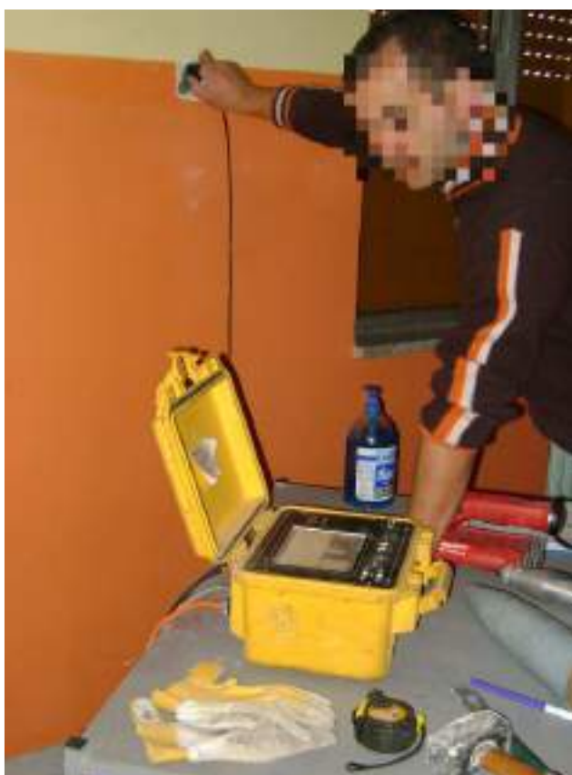
Figura 61 - Ultrasuoni pilastro P/PT/16
