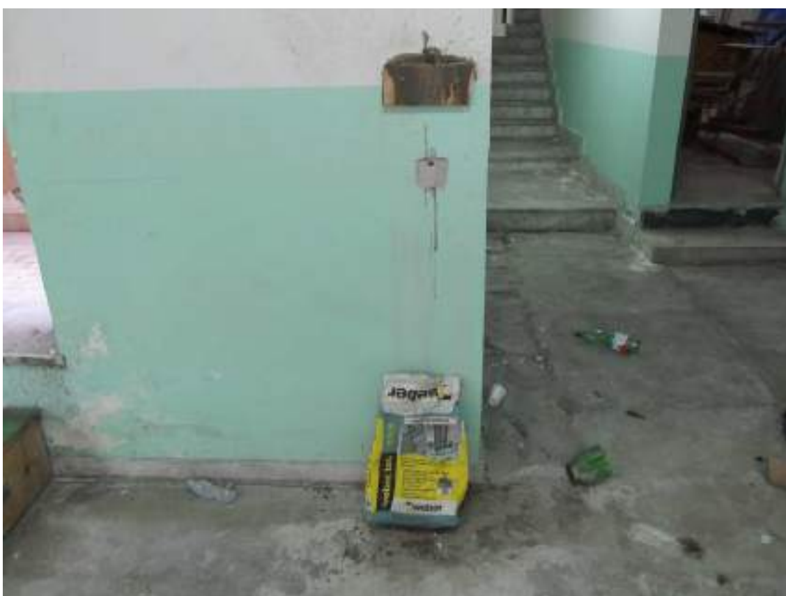
Figura 43 – Ripristino strutturale dei fori di carotaggio con malta antiritiro ad elevata resistenza
