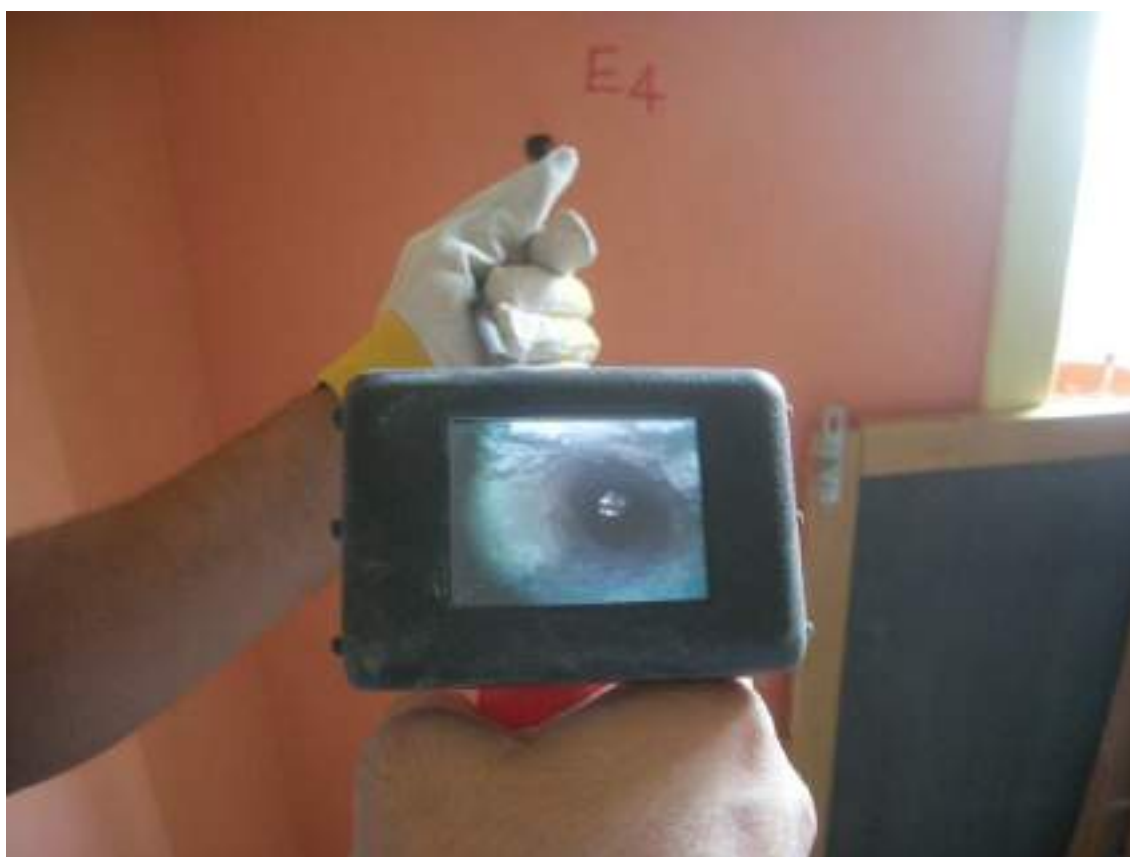
Figura 4 – Indagine endoscopica muratura (E4, Corpo A).
