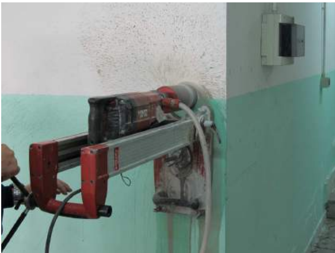
Figura 40 – Esecuzione carotaggio C8
