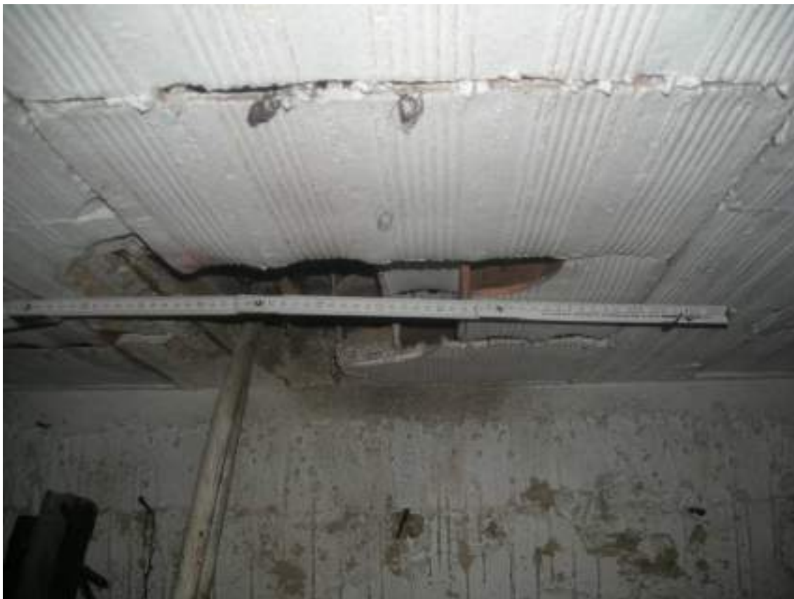
Figura 23 - Saggio esplorativo solaio (SS4, Corpo B).
