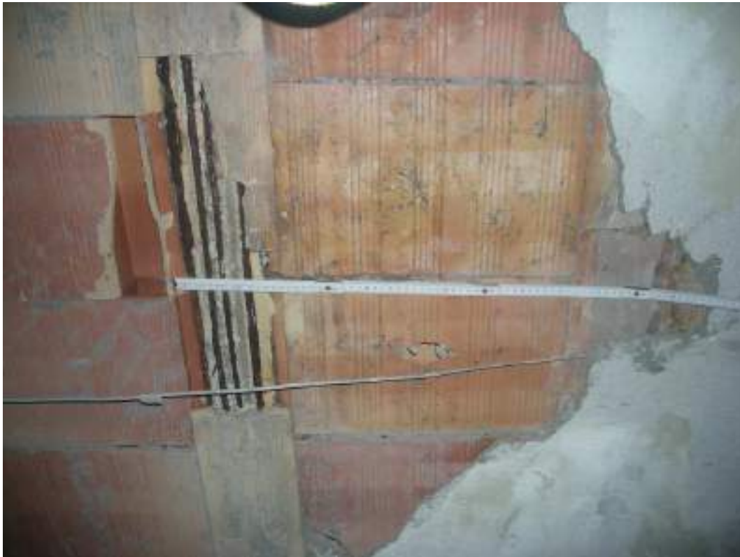
Figura 5 – Saggio solaio (SS1 – Corpo A).
