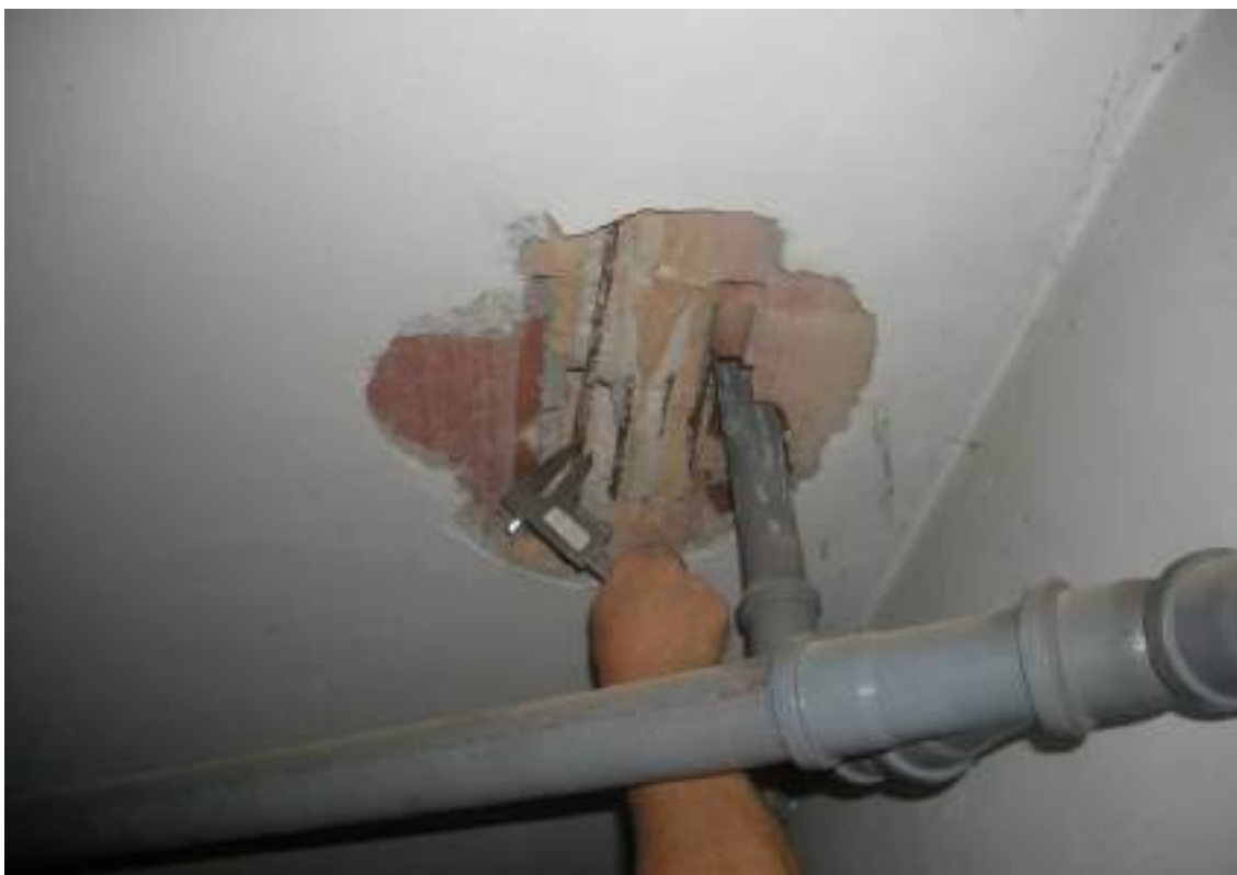
Figura 21 – Saggio esplorativo solaio (SS2, Corpo A).
