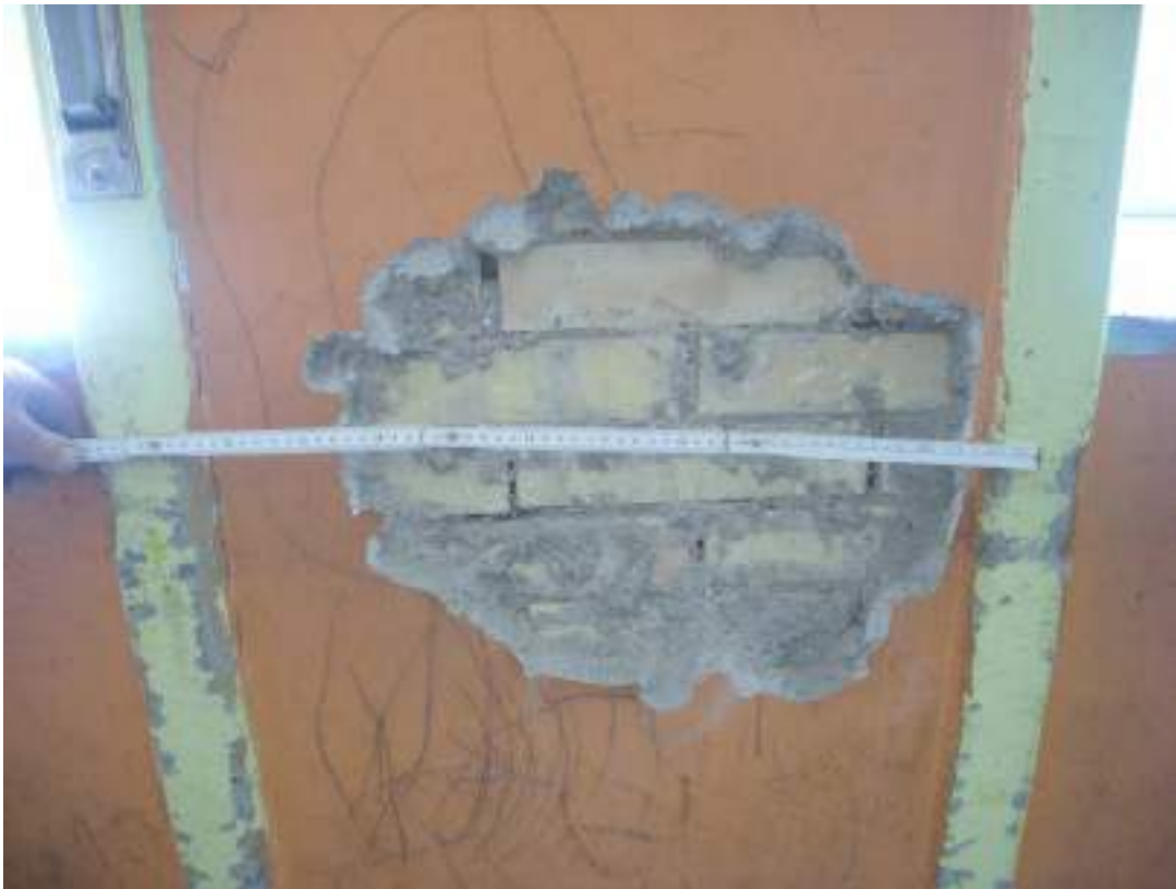
Figura 4 - Saggio diretto su muratura (SM6, corpo A).
