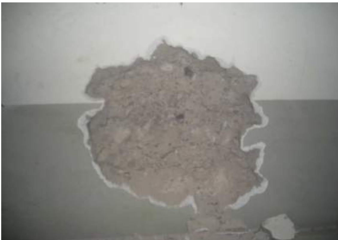
Figura 10 - Saggio esplorativo muratura PS: parete in calcestruzzo (SM1, Corpo A).
