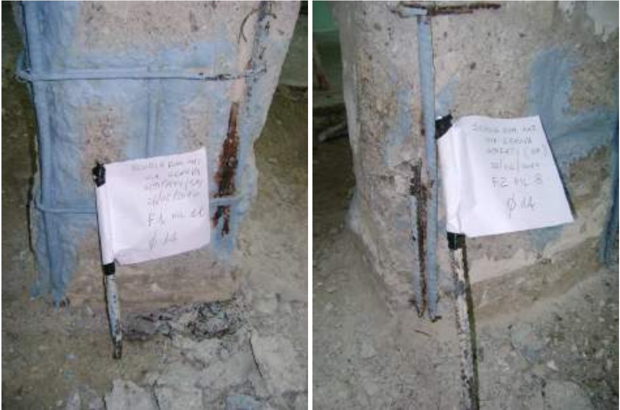
Figure 13 e 14 – Prelievo barra acciaio (F1= Ø14; F2=Ø14).
