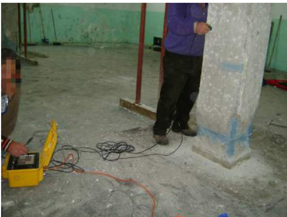
Figura 47 - Ultrasuoni pilastro P/PS/10
