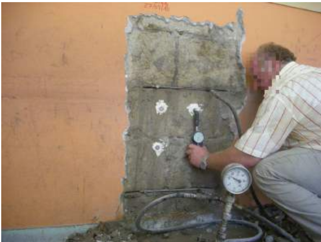
Figura 6 - Esecuzione prova con martinetti piatti doppi (MP1)
