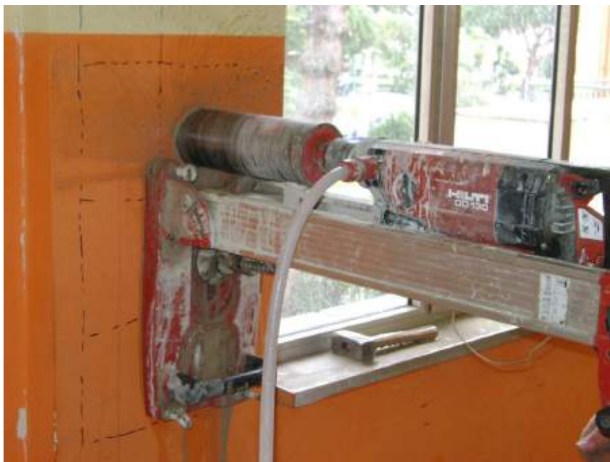
Figura 10 - Esecuzione di un carotaggio in un pilastro.
