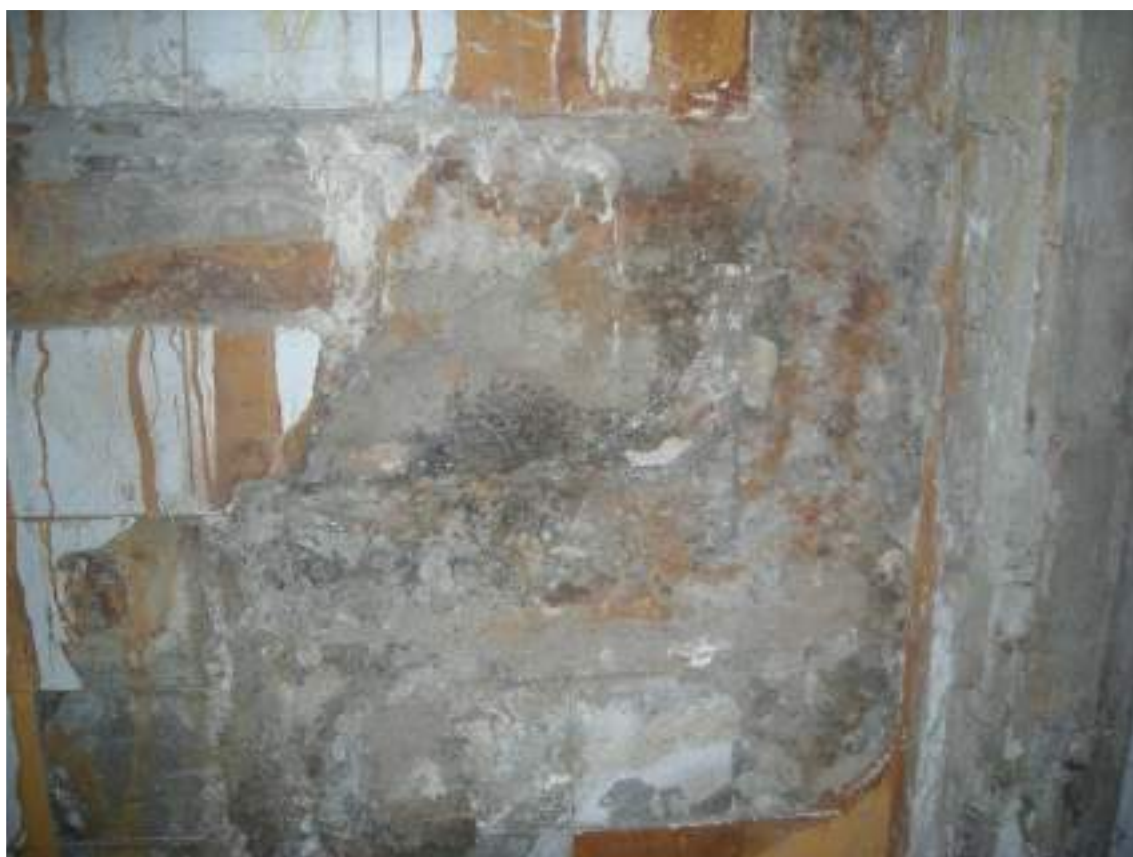
Figura 13 – Saggio esplorativo muratura PS: parete in calcestruzzo (SM4, Corpo A).
