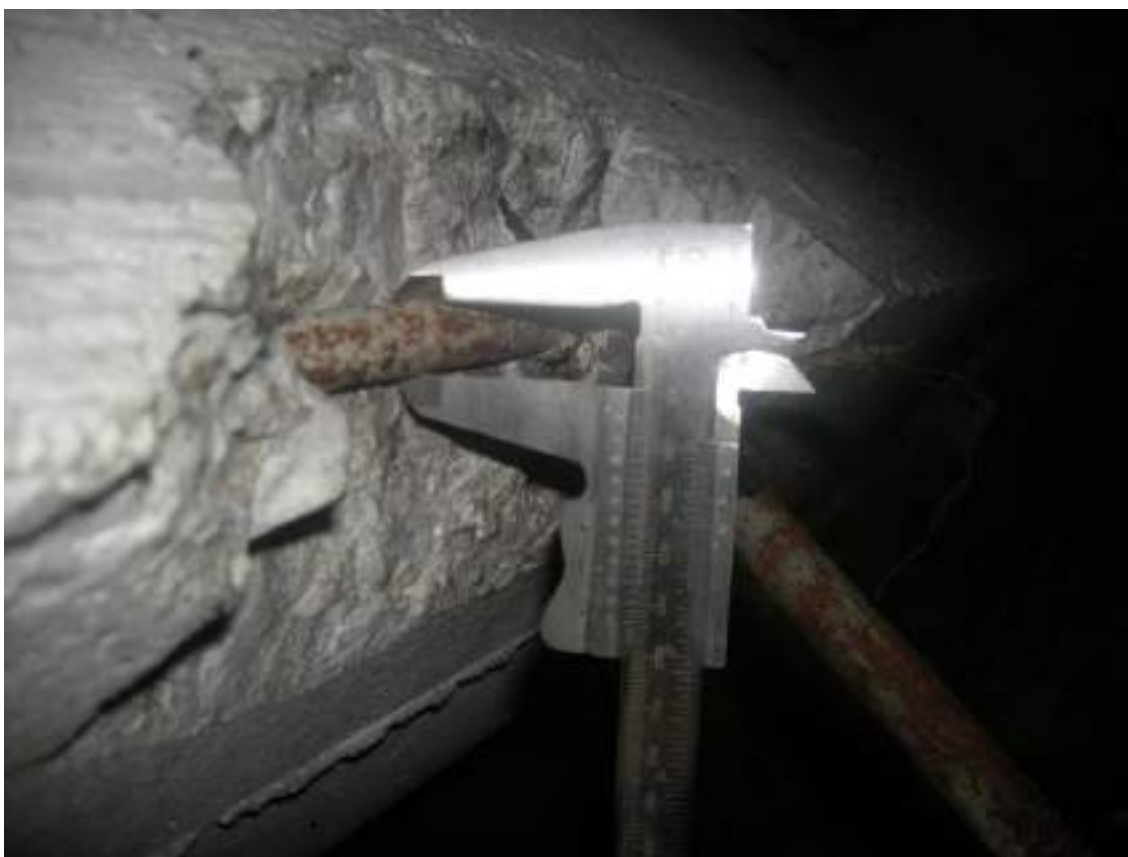
Figura 25 – Saggio esplorativo trave:Ø14 (Corpo B, PS).
