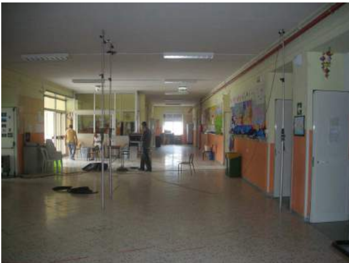
Figura 30 - Sensori elettronici di rilevazione
