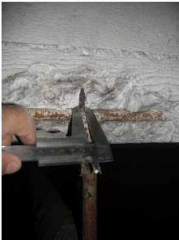
Figura 26 – Saggio esplorativo trave:staffa Ø8 (Corpo B, PS).
