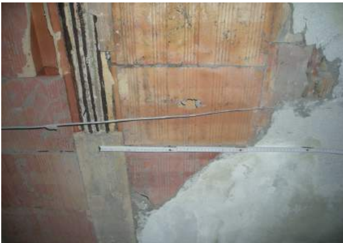
Figura 20 – Saggio esplorativo solaio (SS1, Corpo A).
