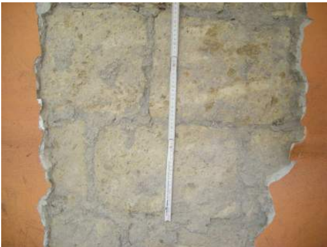
Figura 14 – Saggio esplorativo muratura: blocchi di tufo (SM5, Corpo A).
