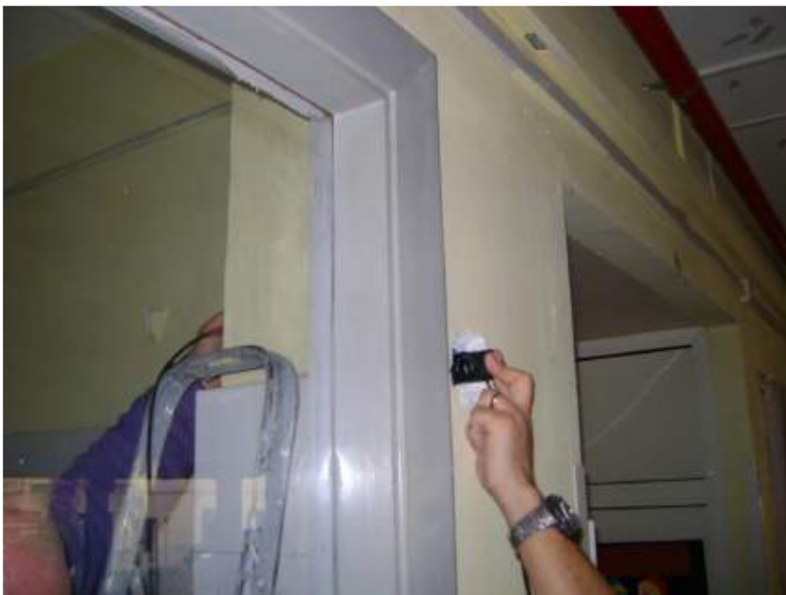
Figura 67 – Ultrasuoni pilastro P/PT/11
