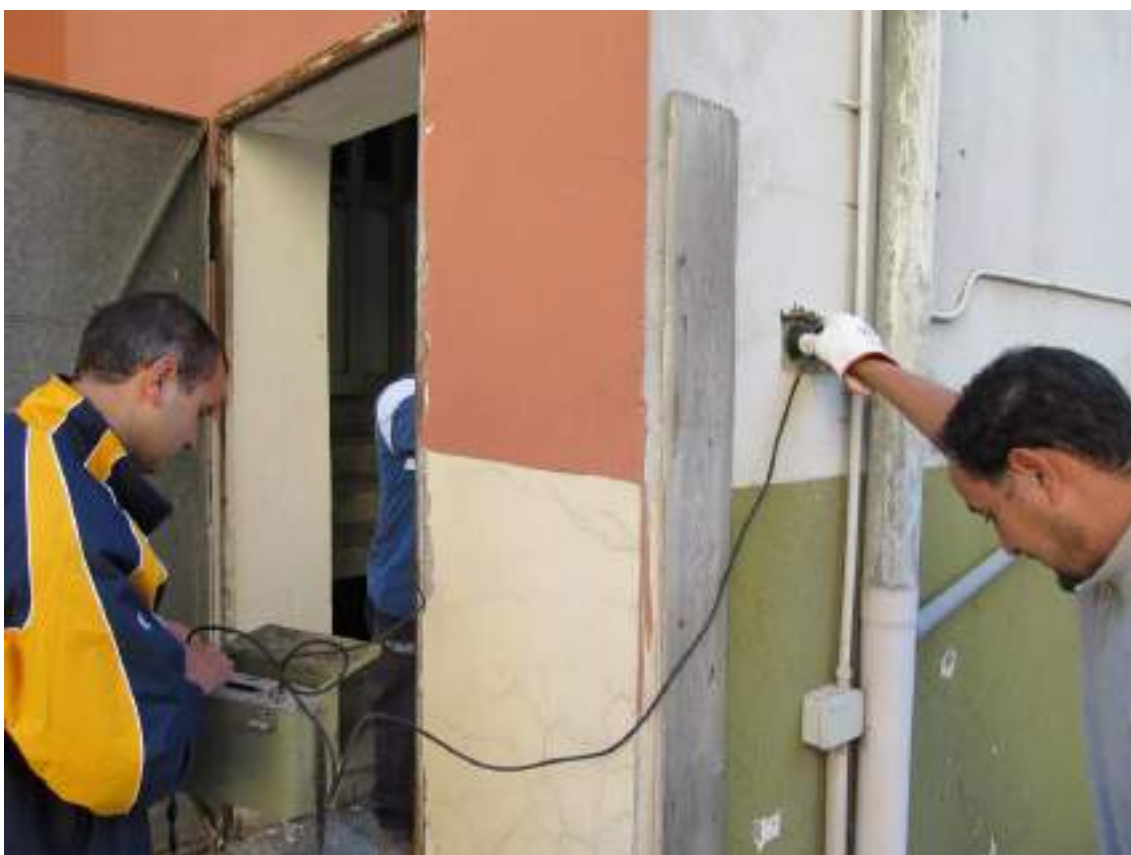
Figura 69 - Ultrasuoni pilastro P/PT/21
