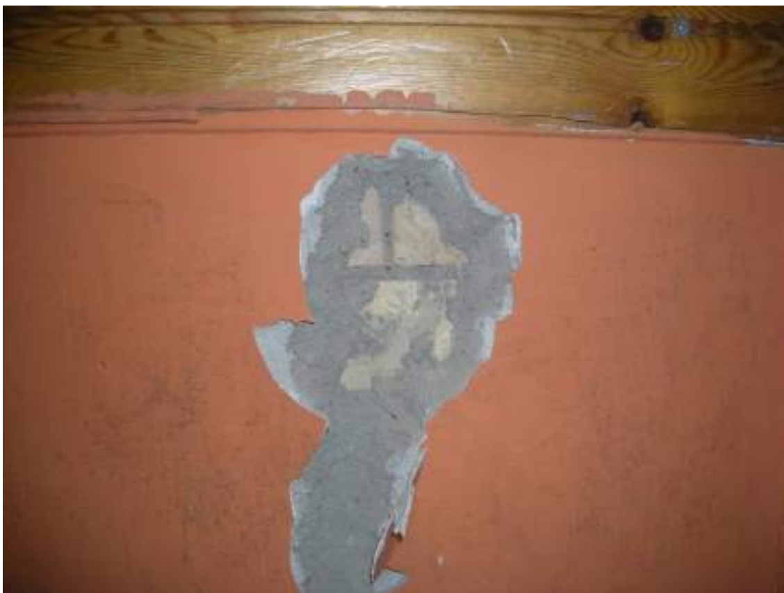
Figura 18 – Saggio esplorativo muratura: pilastro in mattoni pieni (SM8, Corpo A).
