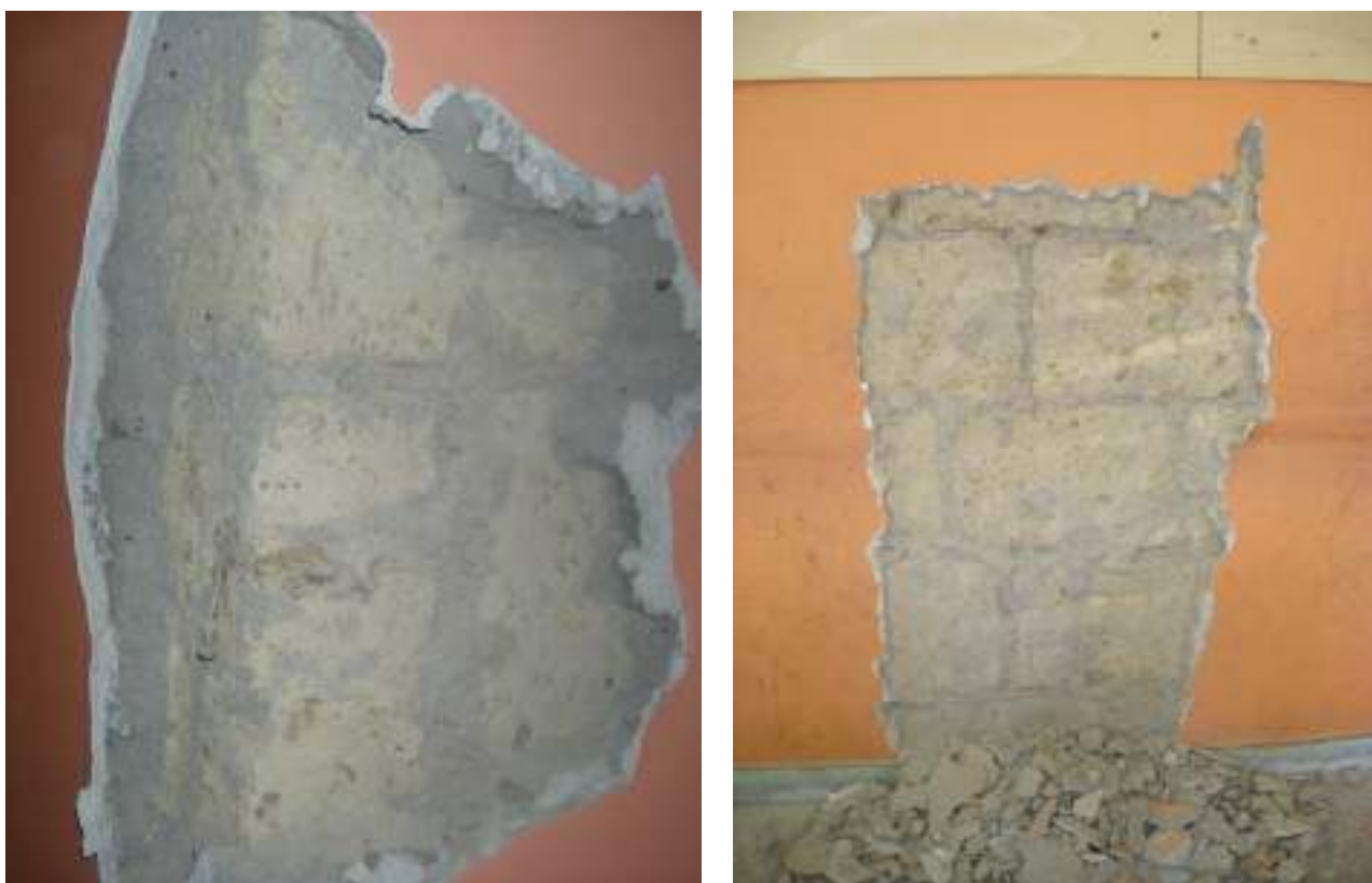
Figure 2, 3 – Saggio diretto su muratura (SM7,SM5 corpo A).
