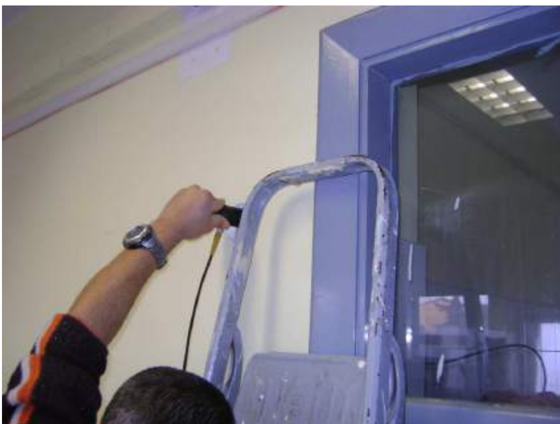
Figura 73 - Ultrasuoni pilastro P/1P/8
