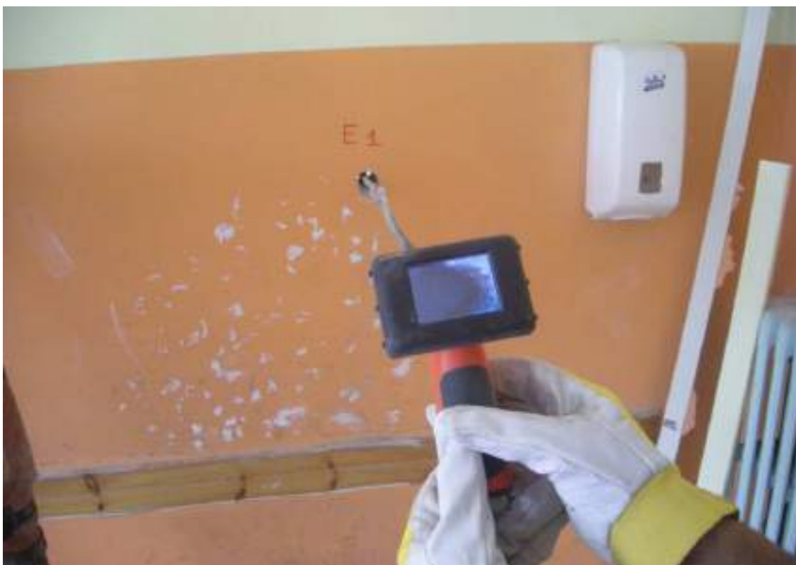
Figura 1 – Indagine endoscopica muratura (E1, Corpo A).
