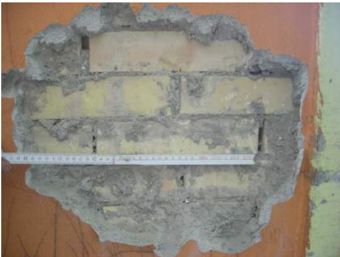
Figura 16 – Saggio esplorativo muratura: pilastro in mattoni pieni (SM6, Corpo A).
