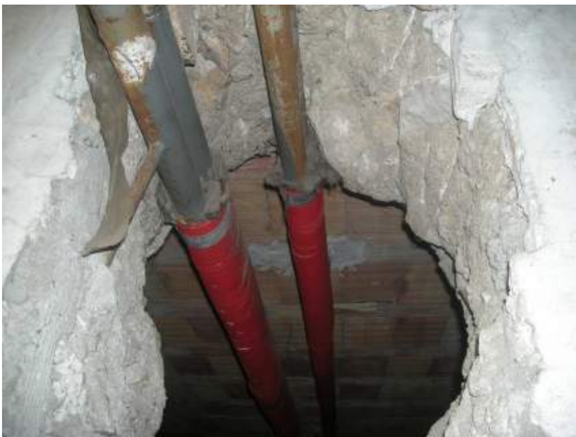
Figura 6 - Indagine endoscopica muratura in foro preesistente (Eb, Corpo A).
