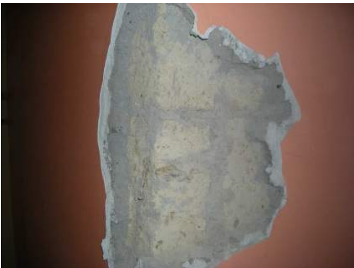
Figura 17 – Saggio esplorativo muratura: blocchi di tufo (SM7, Corpo A).
