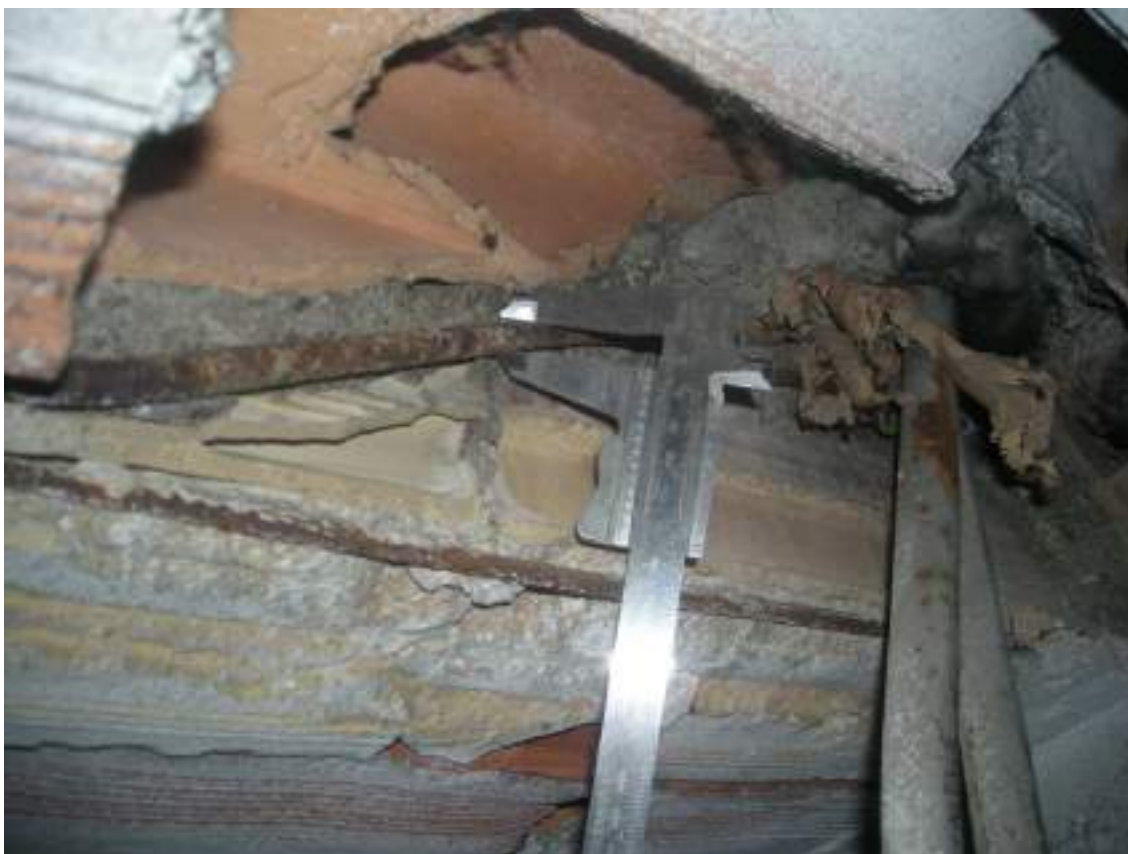
Figura 24 – Saggio esplorativo solaio (SS4, Corpo B).
