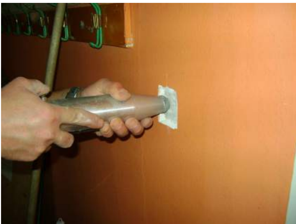
Figura 59 – Sclerometria pilastro P/PT/9
