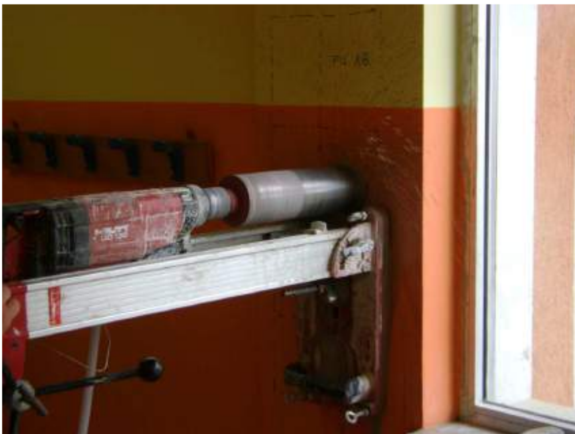
Figura 37 - Esecuzione carotaggio C5
