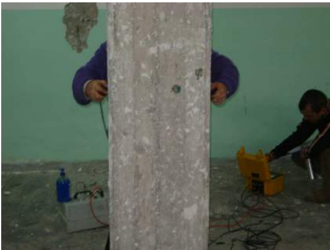
Figura 50 - Ultrasuoni pilastro P/PS/8
