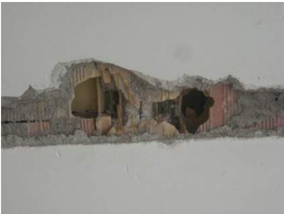
Figura 22 – Saggio esplorativo solaio (SS3, Corpo A).
