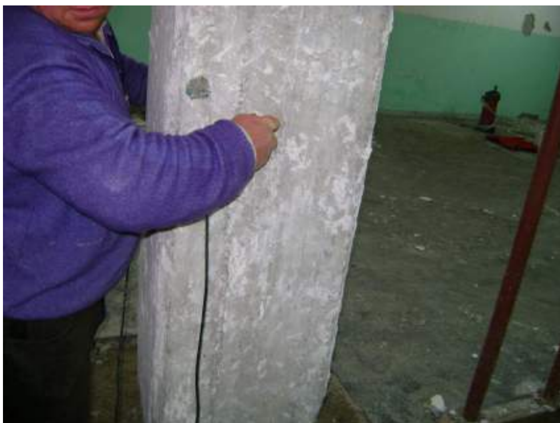
Figura 49 - Ultrasuoni pilastro P/PS/9
