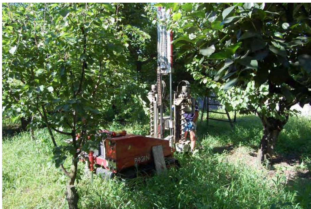
Prova penetrometrica dinamica pesante DPSH1
