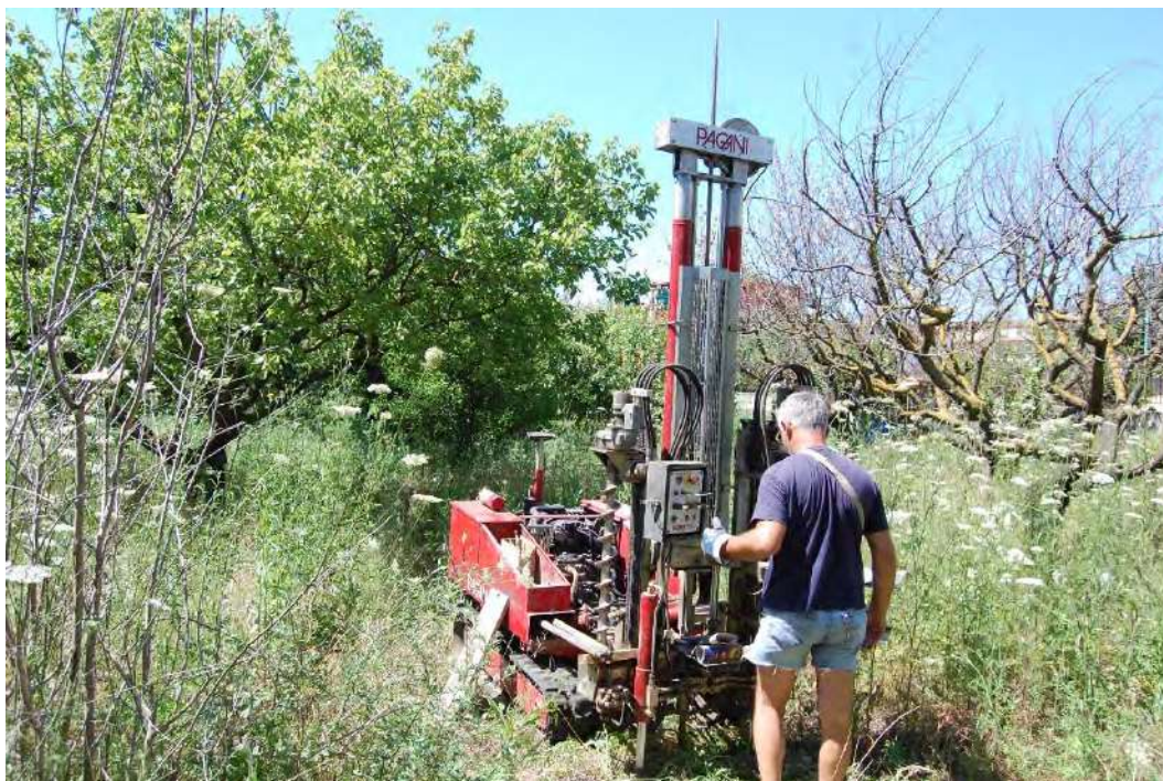
Prova penetrometrica dinamica pesante DPSH2
