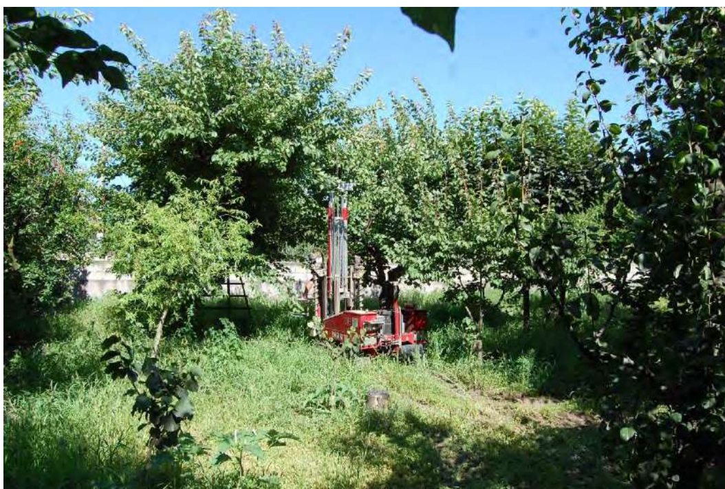
Prova penetrometrica dinamica pesante DPSH1
