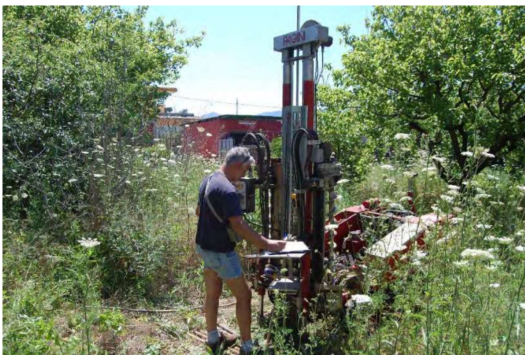
Prova penetrometrica dinamica pesante DPSH2
