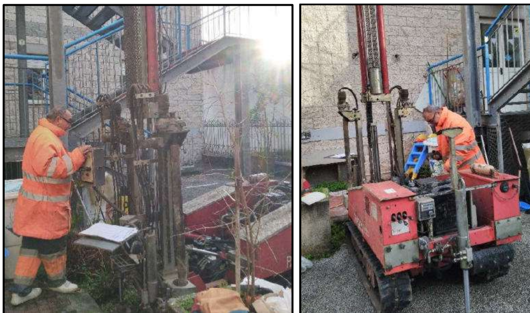
Figura 6.14 – Foto di campo delle Indagini Penetrometriche DPSH_1
