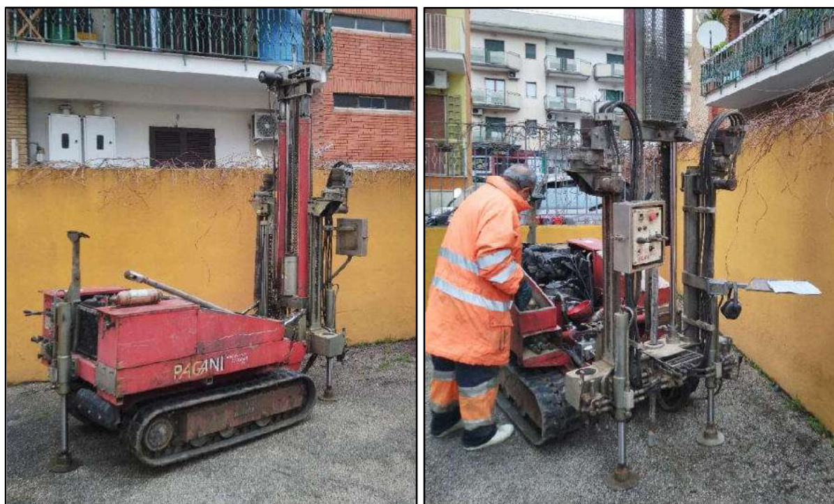
Figura 6.18 – Foto di campo delle Indagini Penetrometriche DPSH_2
