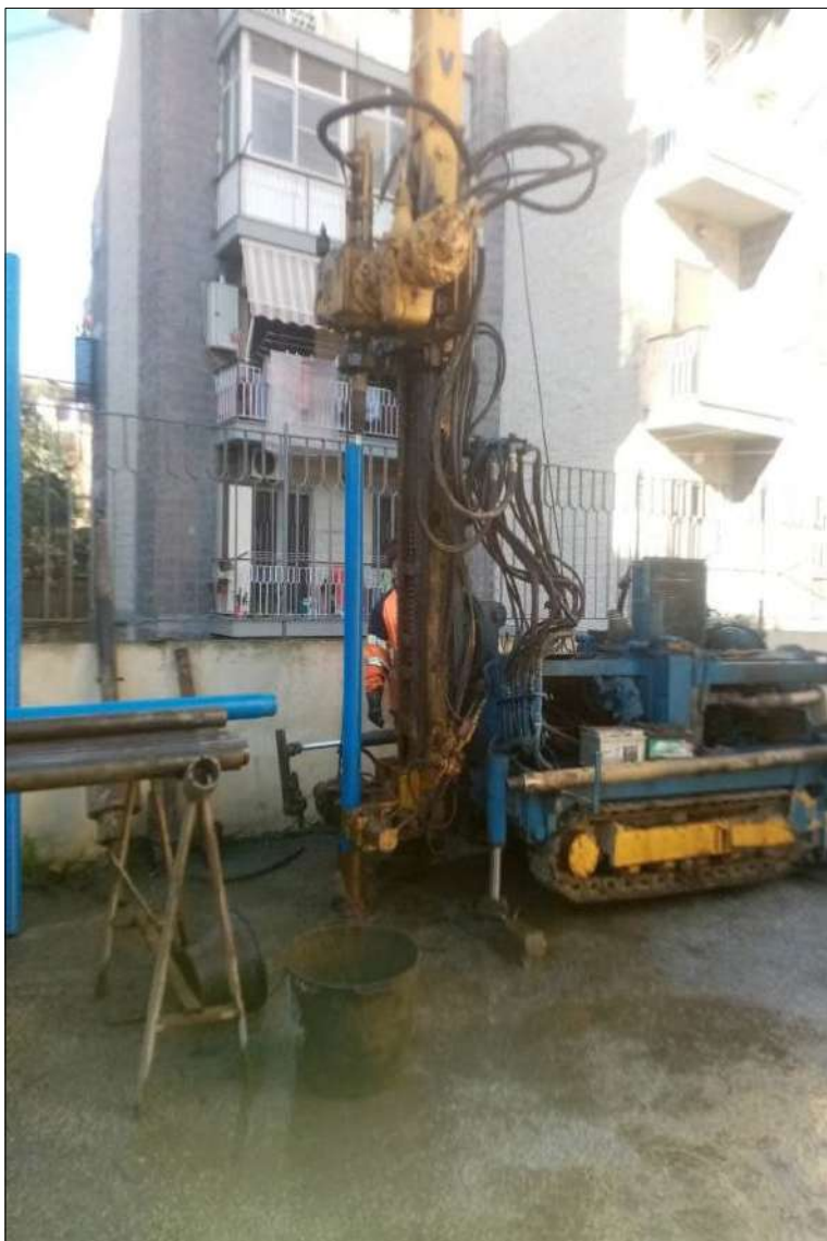
Rivestimento per prova Down-Hole
