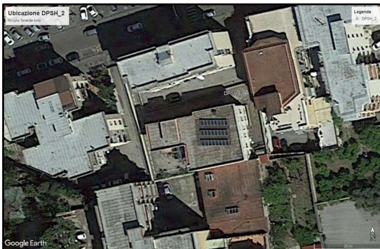
Figura 6.16. Ubicazione della prova DPSH_2
