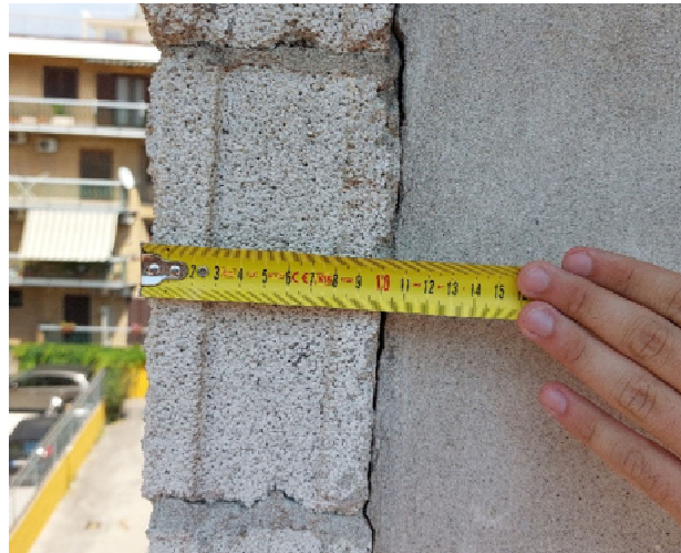
Figura 12 – Rilievo spessore rivestimento esterno.
