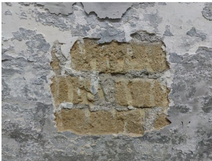
Figura 14 – Saggio su muratura di tufo presente al piano seminterrato.
