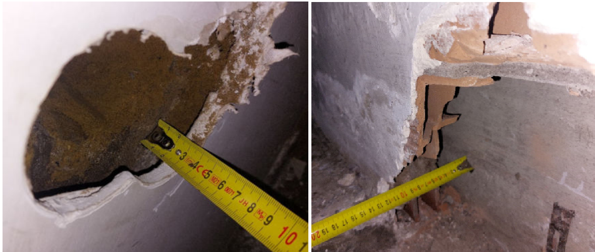
Figura 15 – Saggio su pareti piano seminterrato. A sx parete lato sud, a dx parete lato est.
