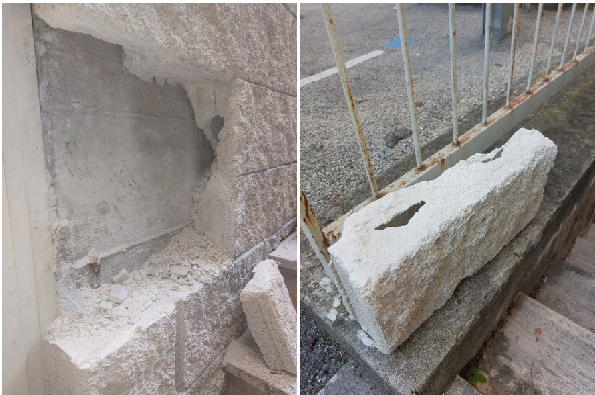
Figura 16 – Prelievo di blocco a faccia vista.
