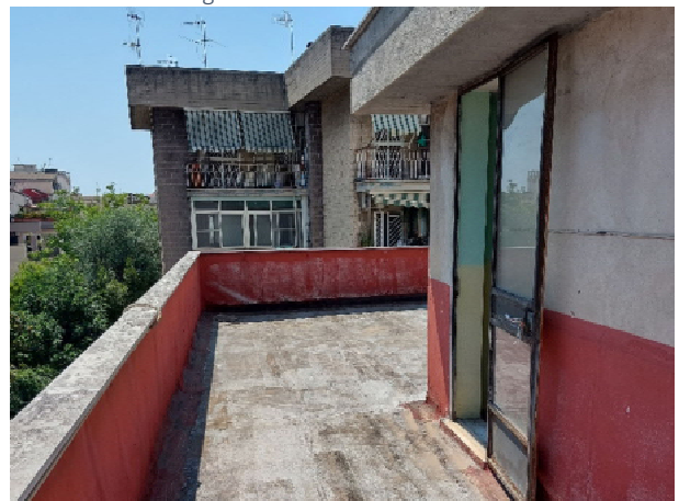
Figura 10 – Accesso lastrico solare da torrino scale
